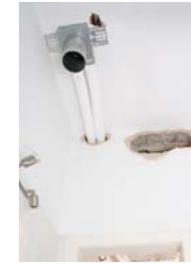
Luftdurchlass innerhalb der später abgehängten Decke
