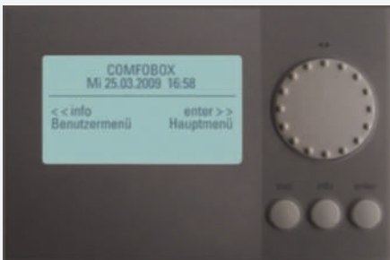
Fig. 6 Zehnder ComfoBox Bedieneinheit (Heizen, Kühlen, Warmwasser)
