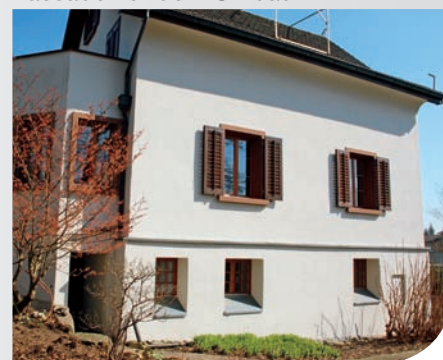
Fassade vor dem Umbau
