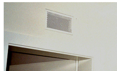
Einbauart ComfoDuct Standard
